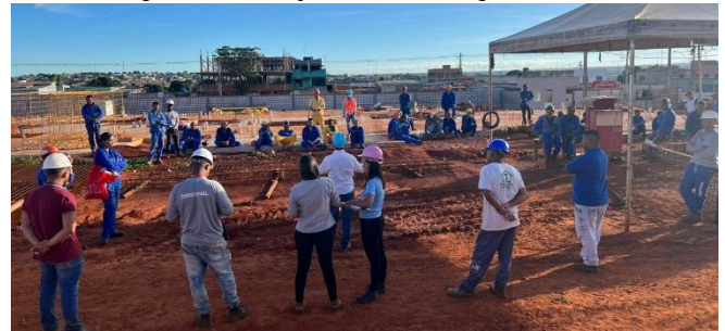
Salvador com os operários em canteiro de obras em Planaltina (DF)
