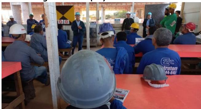
Obra no Setor Sudoeste (DF)
